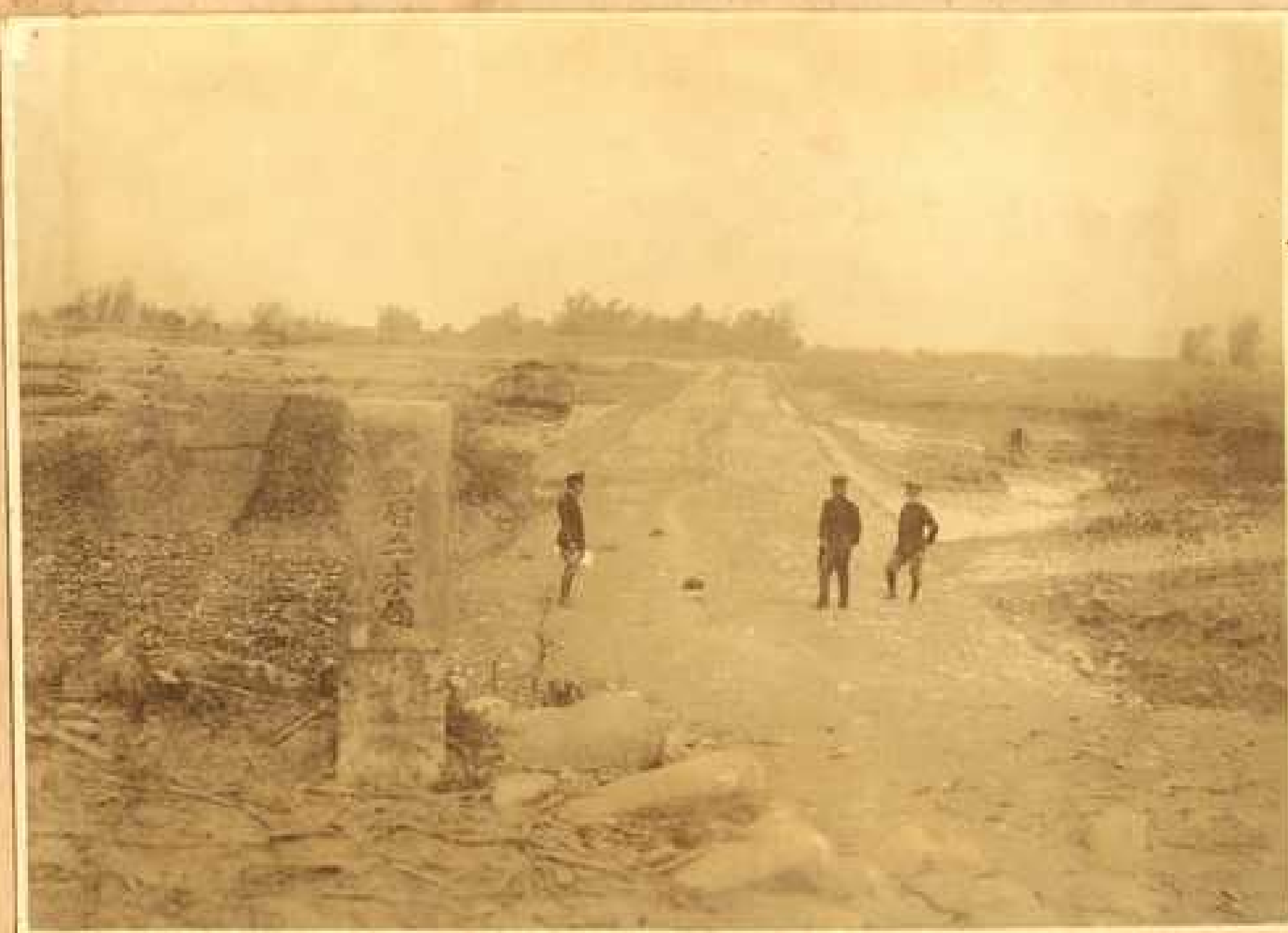
リヨ(近附落部岩半頂)防堤内子湖 現 \times ル \div 前敷利砂 \div ル至 = 落部内子湖 \div リ \times 了終在
